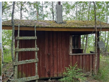
Saunarakennus vanhalta lomarakennuspaikalla
